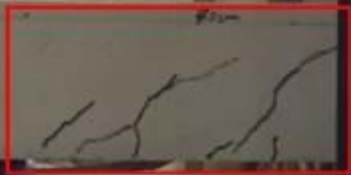
Fissuras de cisalhamento
